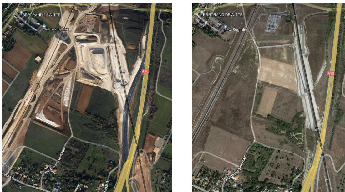
Figure 1 : Zone du projet pendant travaux (à gauche) et actuellement (à droite)
